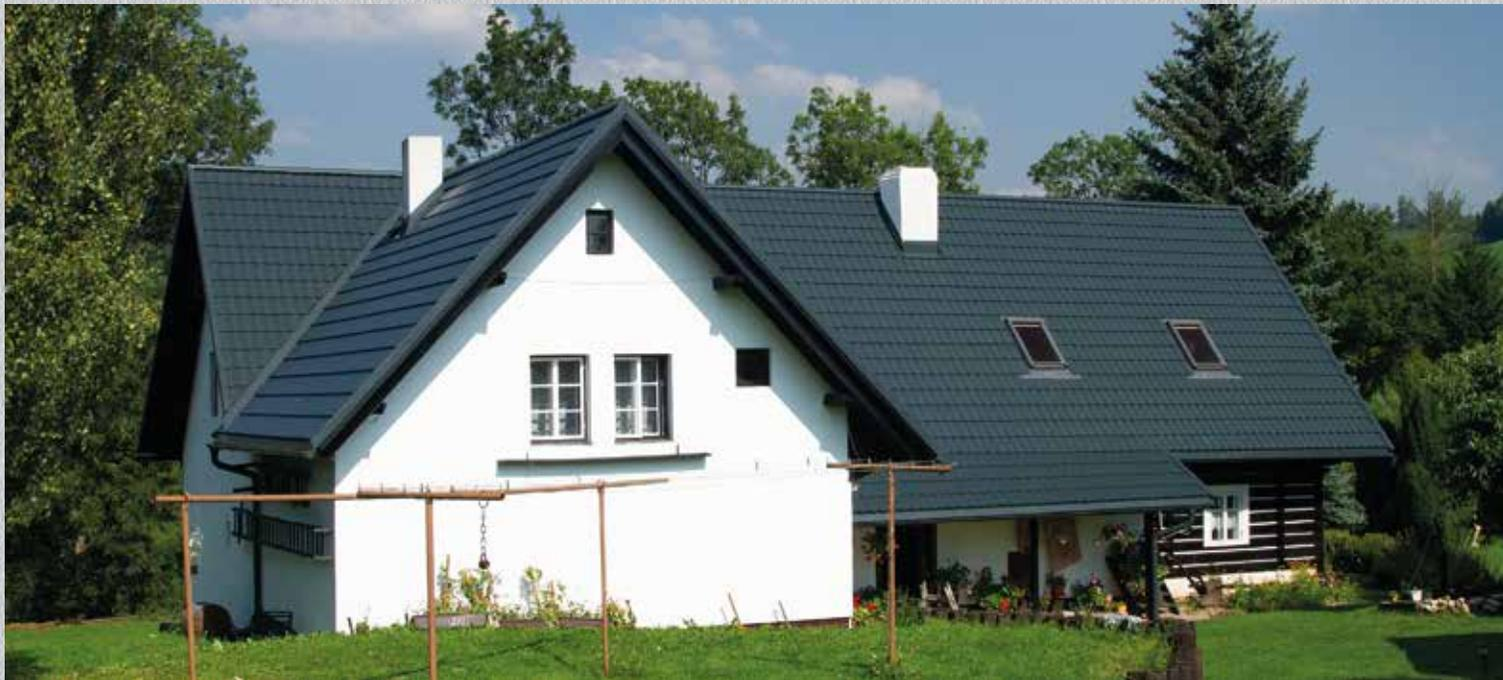
Кровельная черепица ALUTECH имеет ту же форму, что и EVERTILE. Эта черепица отличается минимальным весом (всего 2,4 кг/м<sup>2</sup>) и высококачественным текстурированным полиэфирным покрытием. В числе преимуществ черепицы ALUTECH отметим следующие: максимальная долговечность при сохранении всех технических преимуществ и классический вид продукта EVERTILE.
