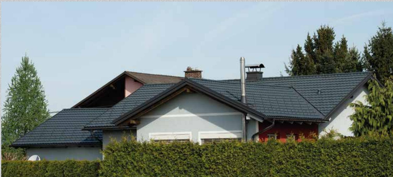
Новое качество гладкой черепицы EVERTECH несет в себе улучшенную технологию нанесения покрытий. Отделка поверхности черепицы EVERTECH 2K представляет собой более прочное матовое покрытие. Прочность и стойкость к коррозии обеспечивается использованием листовой стали высшего качества толщиной 0,45 мм с покрытием АЛЮЦИНК. Черепица легкая (всего 4,5 кг/м<sup>2</sup>) и обладает высокой устойчивостью к загрязнению и произрастанию мха.
