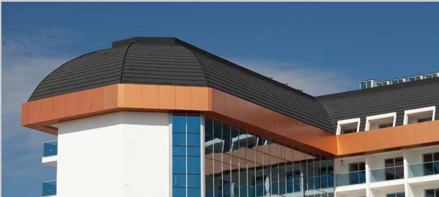
Кровельный продукт EVOQ имеет множество преимуществ в техническом и монтажном плане, а также наиболее широкий спектр аксессуаров. Элементы продукта можно подрезать до нужного размера и подгонять друг к другу на месте, а обрезки использовать снова. Такая возможность снижает уровень отходов и общие затраты. Линейка аксессуаров продолжает расширяться и совершенствоваться, и сейчас EVOQ является одним из наиболее удобных для потребителей продуктов с набором аксессуаров для профессионального монтажа.
